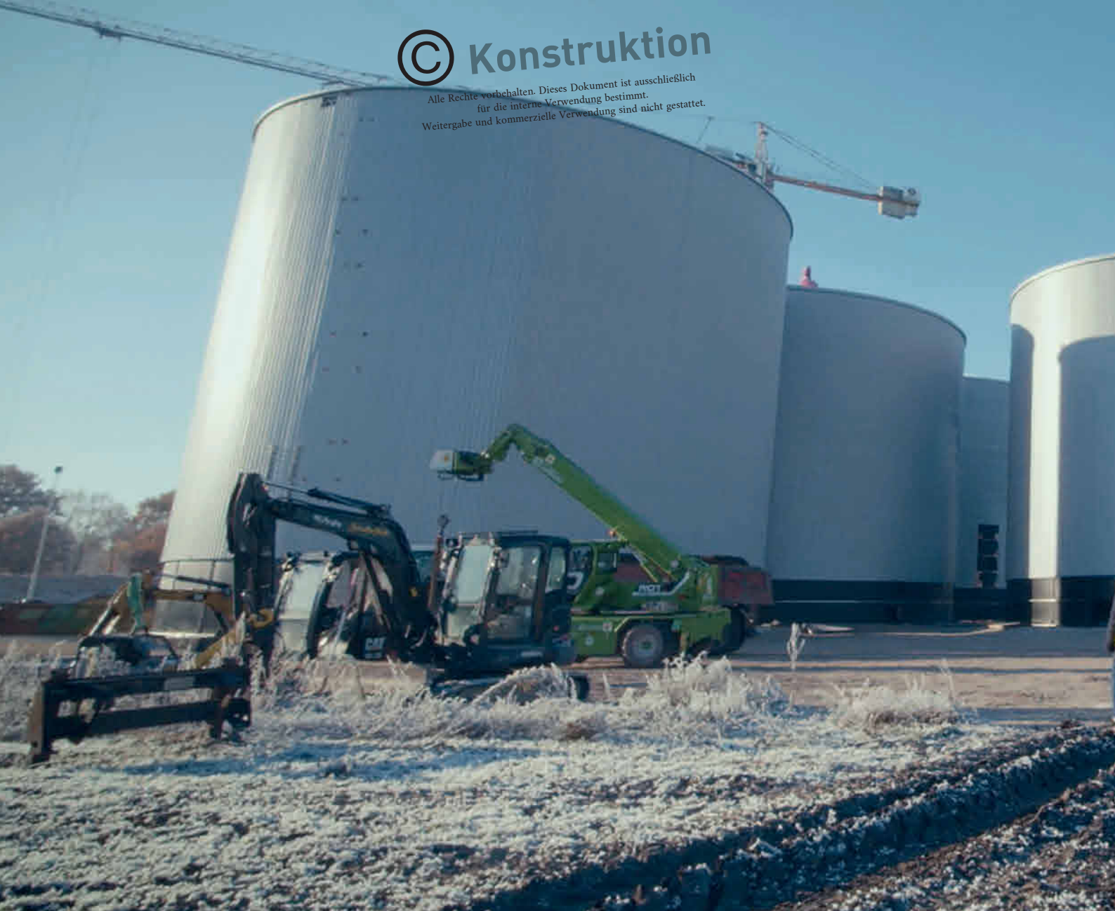
Bild 1: Anspruchsvolles Großprojekt: Bei Friesoythe in Niedersachsen entsteht die größte Biomethananlage Europas. Foto: Nord Drivesystems
